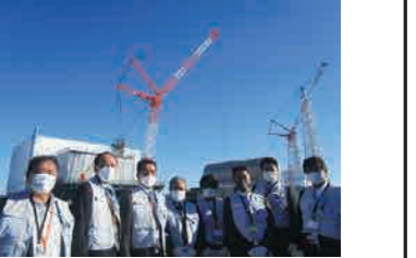
福島第一原発廃炉現場
