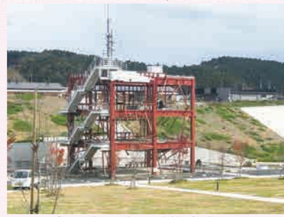
南三陸町防災対策庁舎跡
